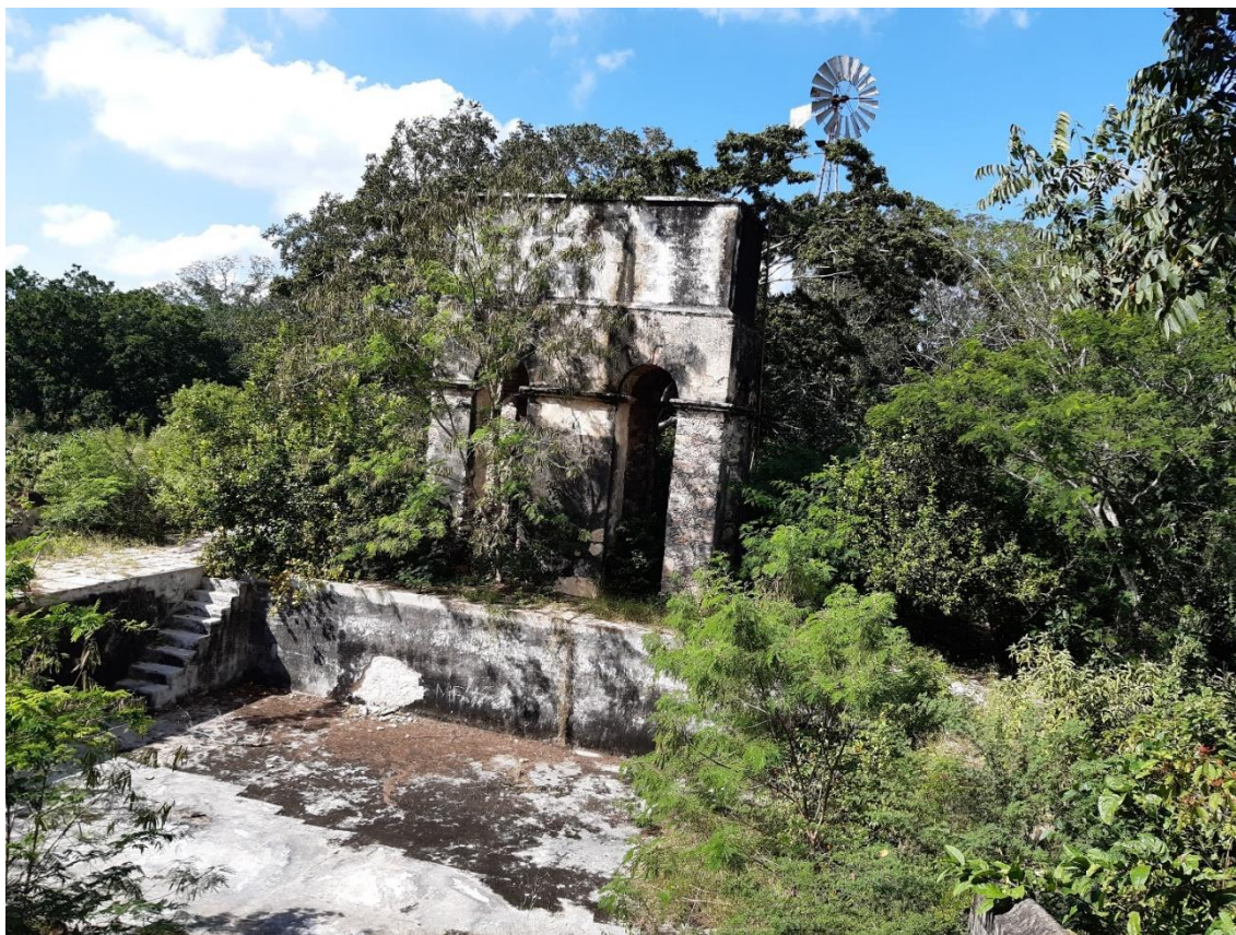
Figura 33. Infraestructura para el abastecimiento de agua en la Hacienda Tabi.
